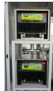
Sistema di accumulo sviluppato in collaborazione con FIAMM Sonick e HTCeramix/SOLIDpower con batterie Sodio Nichel Cloruri e generatore SOFC
