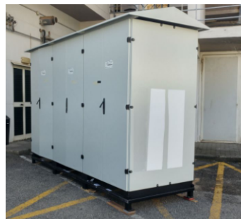
Sistema di accumulo sviluppato in collaborazione con FIAMM Sonick e HTCeramix/SOLIDpower con batterie Sodio Nichel Cloruri e generatore SOFC
